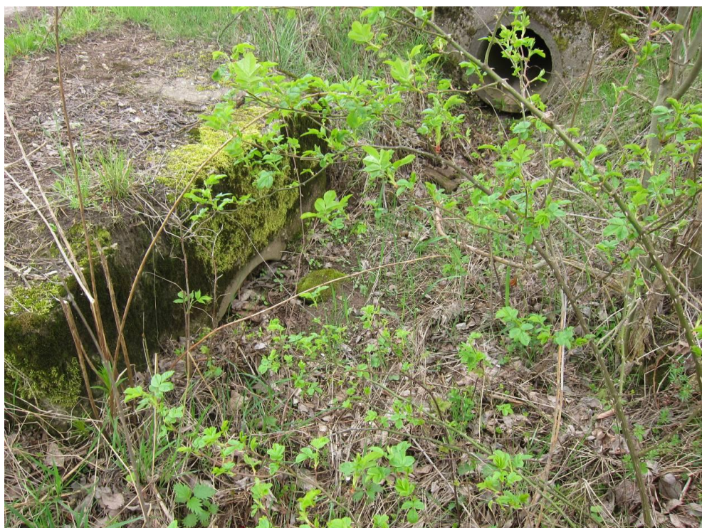
Obr. 22: Pohled na zanesený propustek
